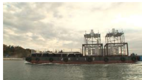
寒風沢水道に運搬中の発電設備(出典:東北復興カレンダー)
