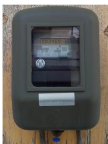
編集部 S の自宅に取り付けられたスマートメーター。円盤がなく数字もデジタル表示です。
