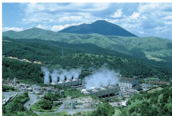
八丁原地熱発電所（大分県）出典：資源エネルギー庁
