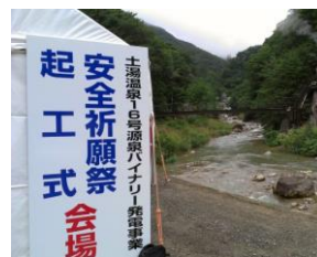
バイナリー発電の起工式（福島県）出典：土湯温泉のブログ
